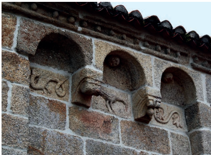
Alero del muro norte de la cabecera
