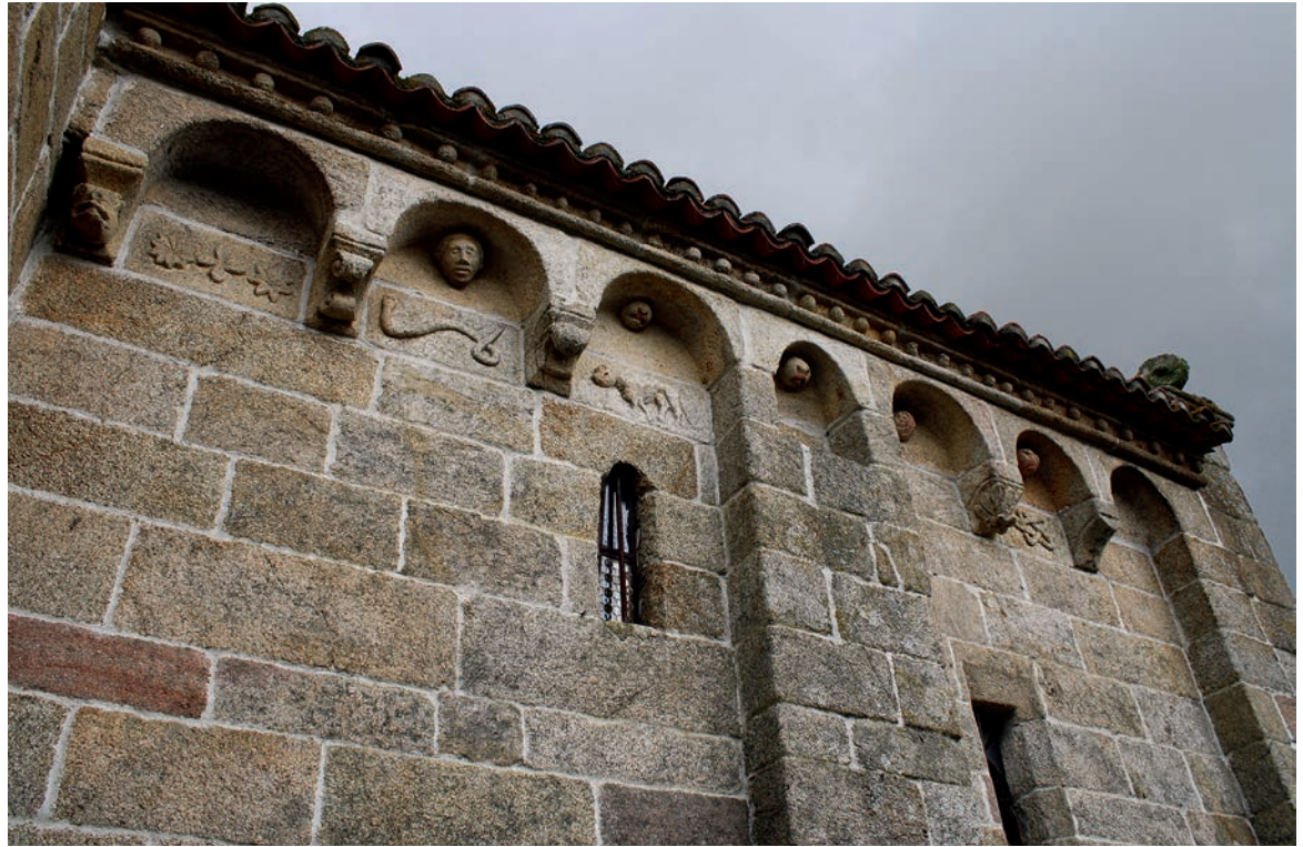
Alero del muro sur de la cabecera
