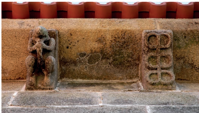
Canecillos del muro norte de la nave
