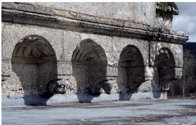
Arquillos del muro sur de la cabecera
