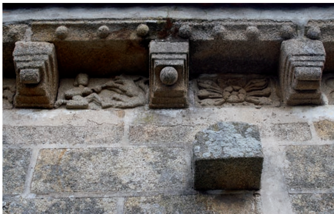
Cornisa del muro sur de la nave
