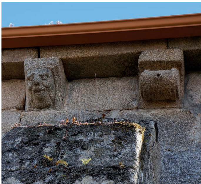
Canecillos del muro norte
