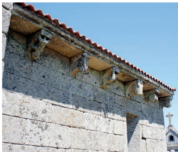
Canecillos del muro sur de la cabecera
