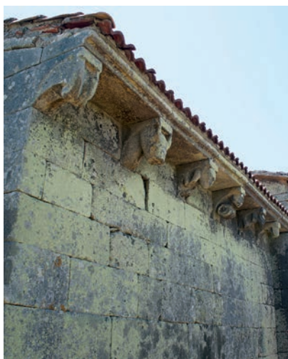
Canecillos del muro norte de la cabecera
