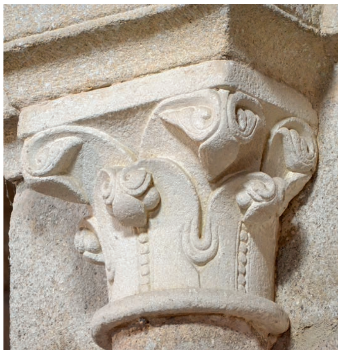
Capiteles de las naves
