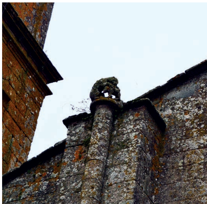
Remate de la fachada oeste
