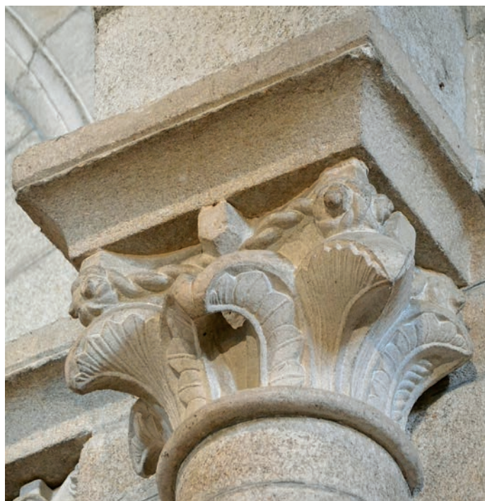
Capiteles de las naves
