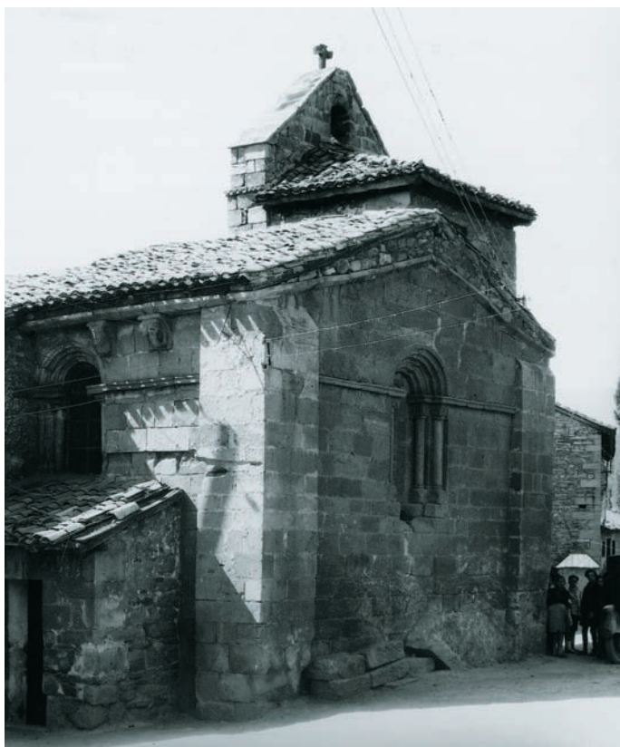
La iglesia antes de la reconstrucción
