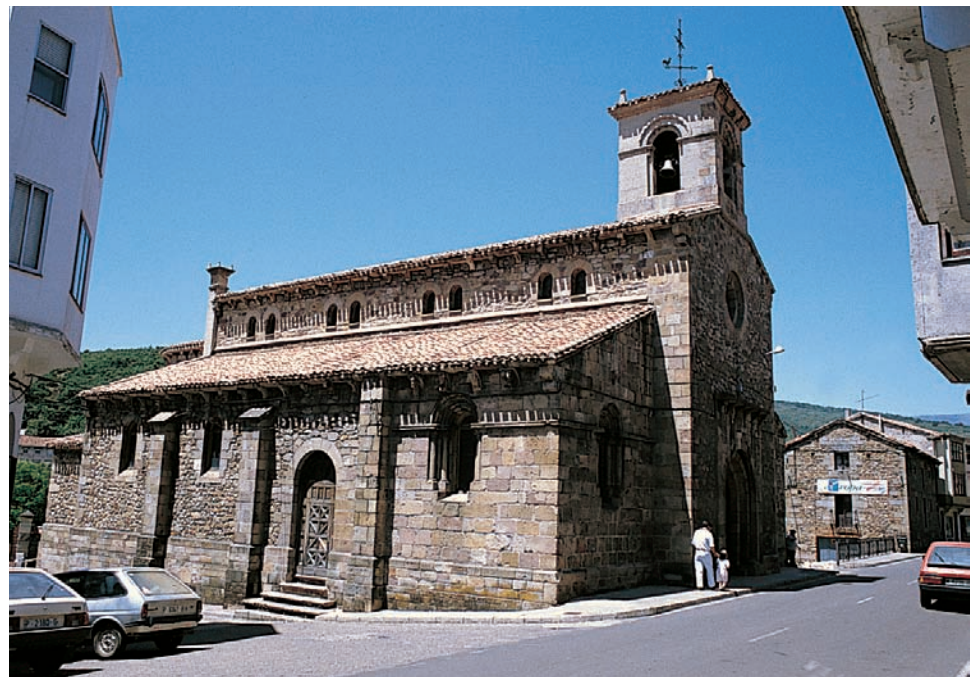
Estado actual del edificio
