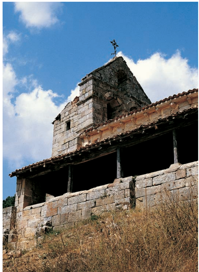
Estructura porticada de San Andrés
