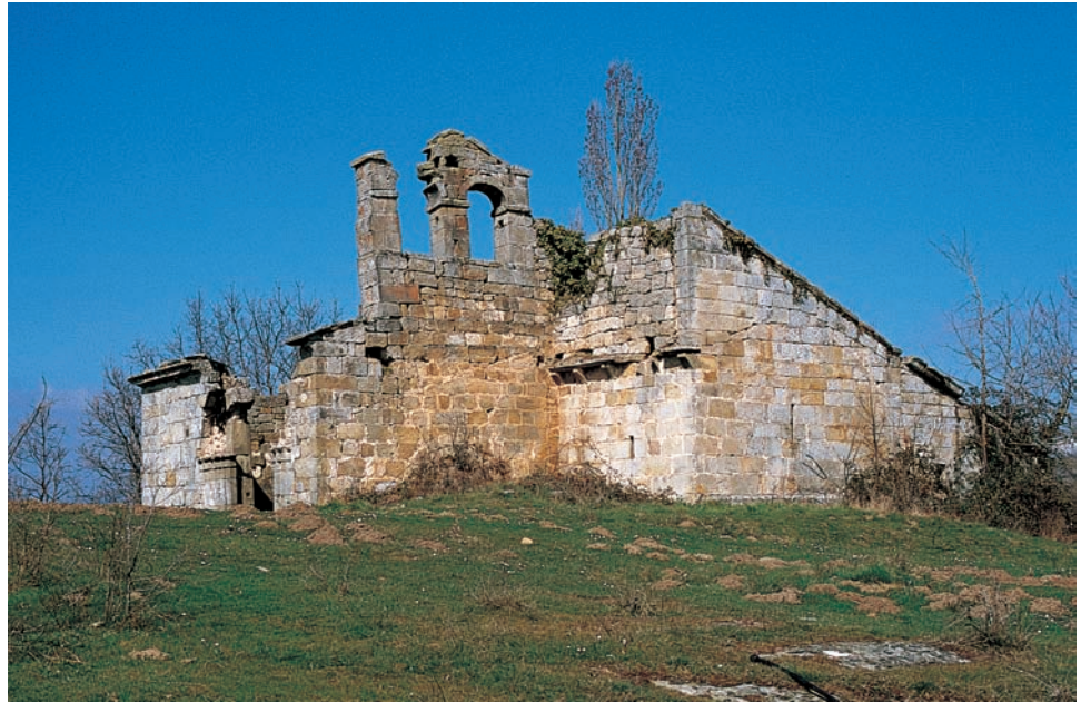
Vista general desde el este
