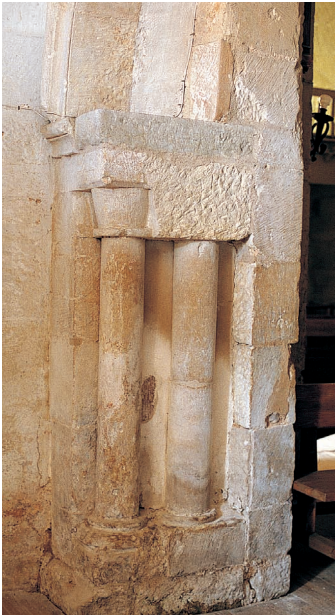
Detalle del interior
