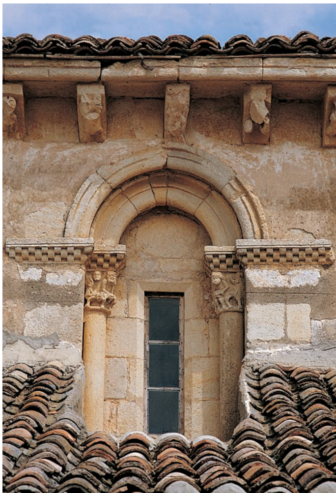
Ventana del muro sur de la nave
