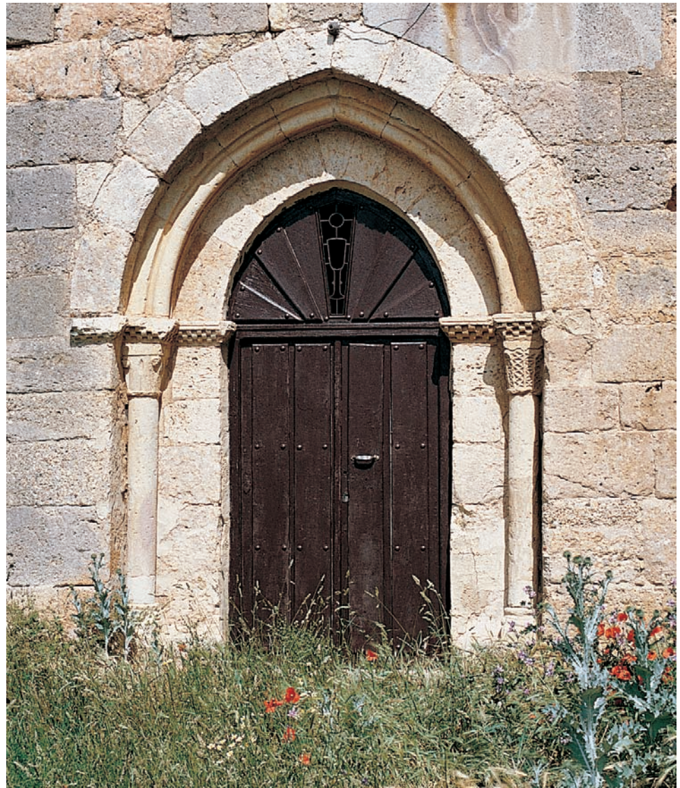
Portada del hastial occidental de la nave norte
