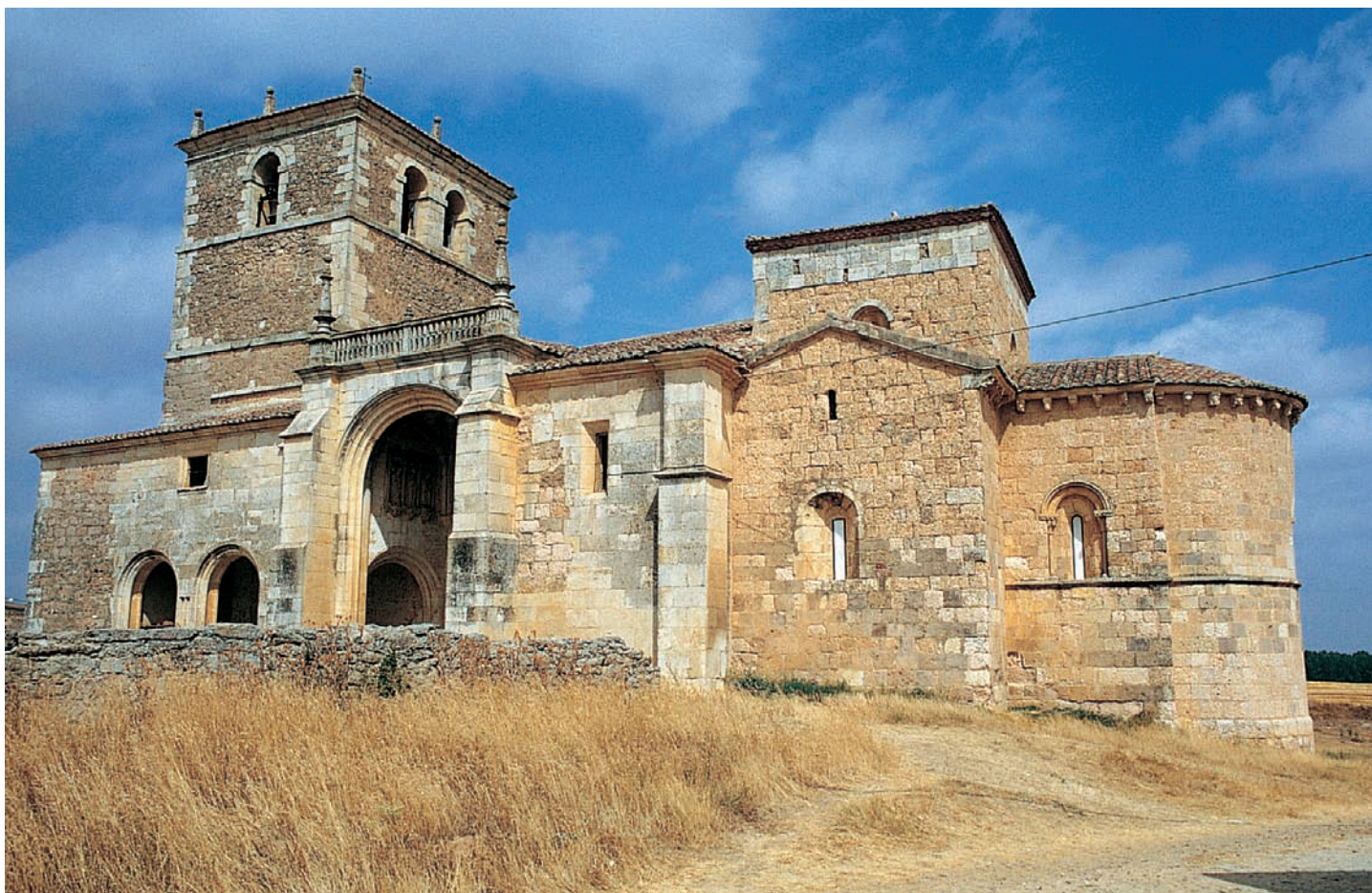
Vista exterior del edificio
