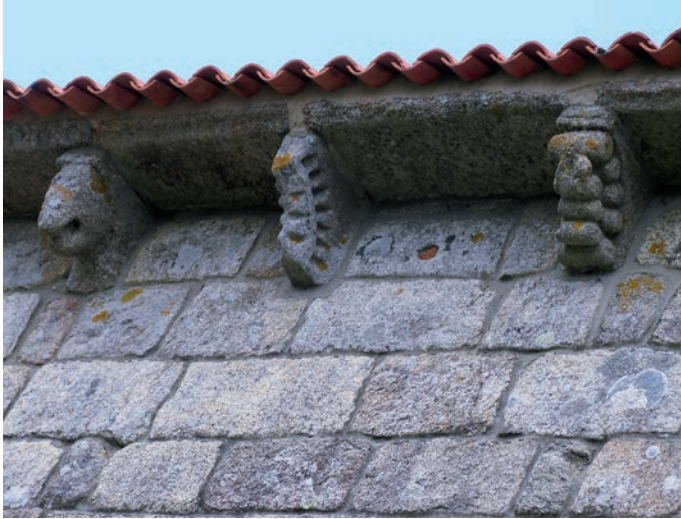
Detalle del alero meridional de la nave
