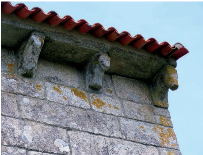
Detalle del alero meridional de la nave
