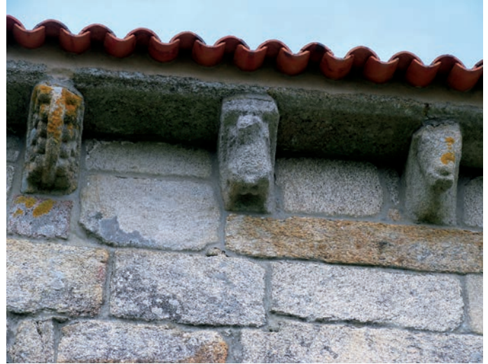
Detalle del alero meridional de la nave
