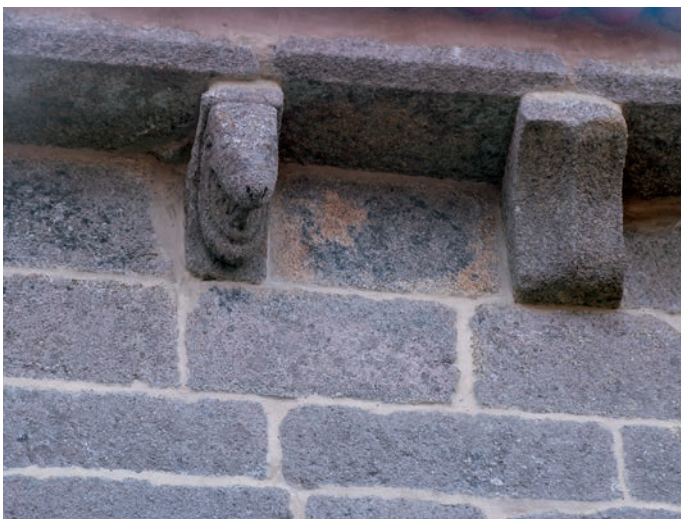
Detalle del alero septentrional de la nave
