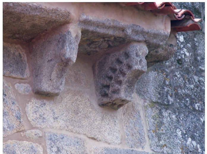
Detalle del alero septentrional de la nave
