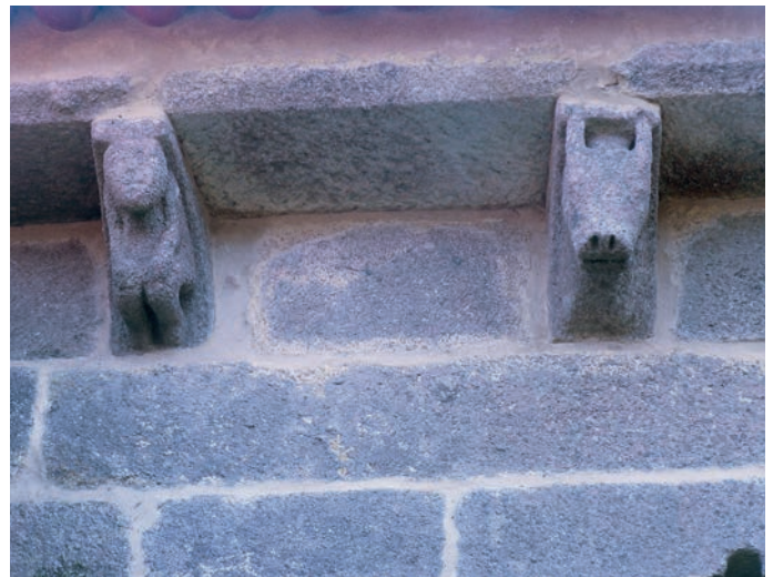
Detalle del alero septentrional de la nave
