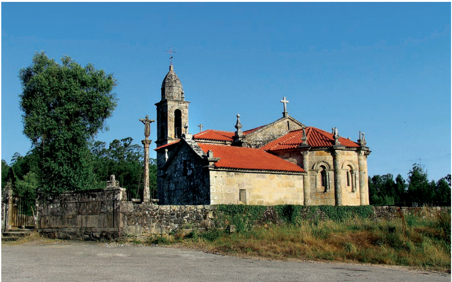
Vista del edificio desde ángulo sudoriental
