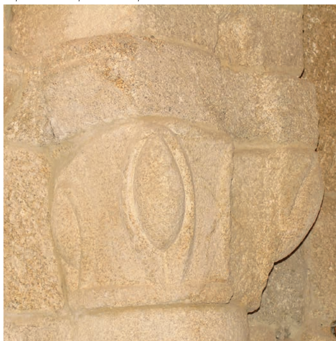
Capitel del muro septentrional del presbiterio
