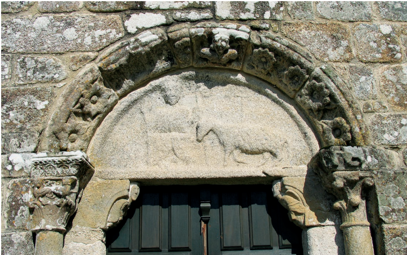
Portada de la fachada occidental
