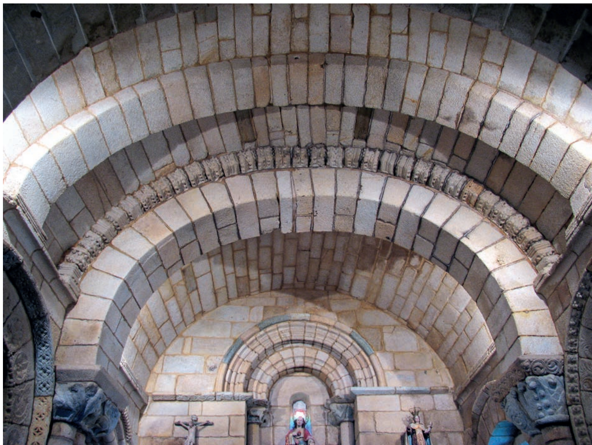
Arcos y bóveda de la cabecera
