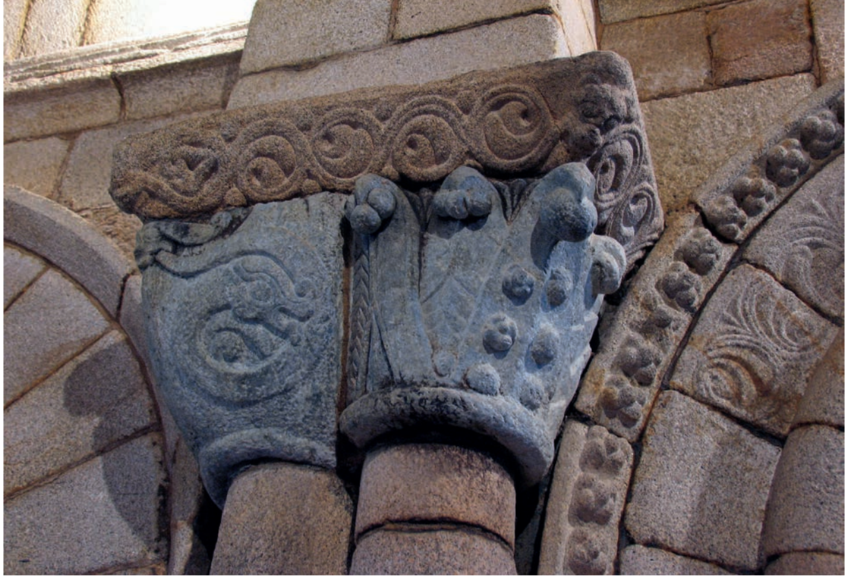
Capitel del arco fajón sur de la cabecera
