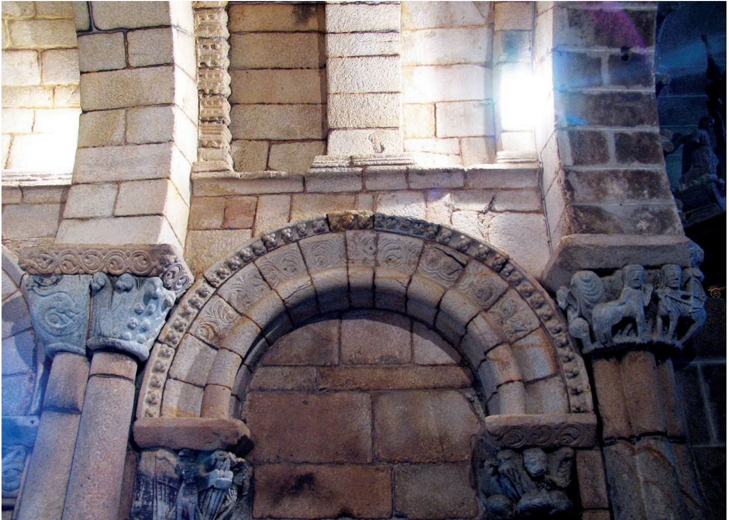
Detalle del muro sur de la cabecera
