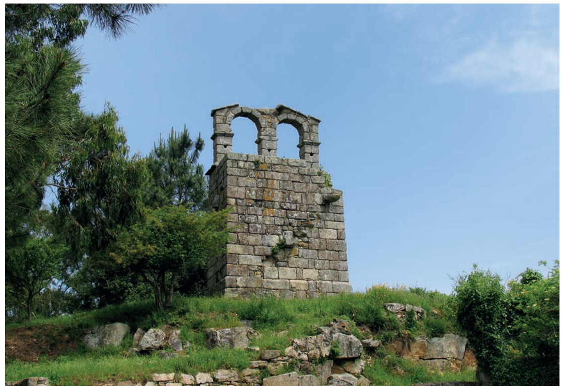
Restos de la torre-campanario
