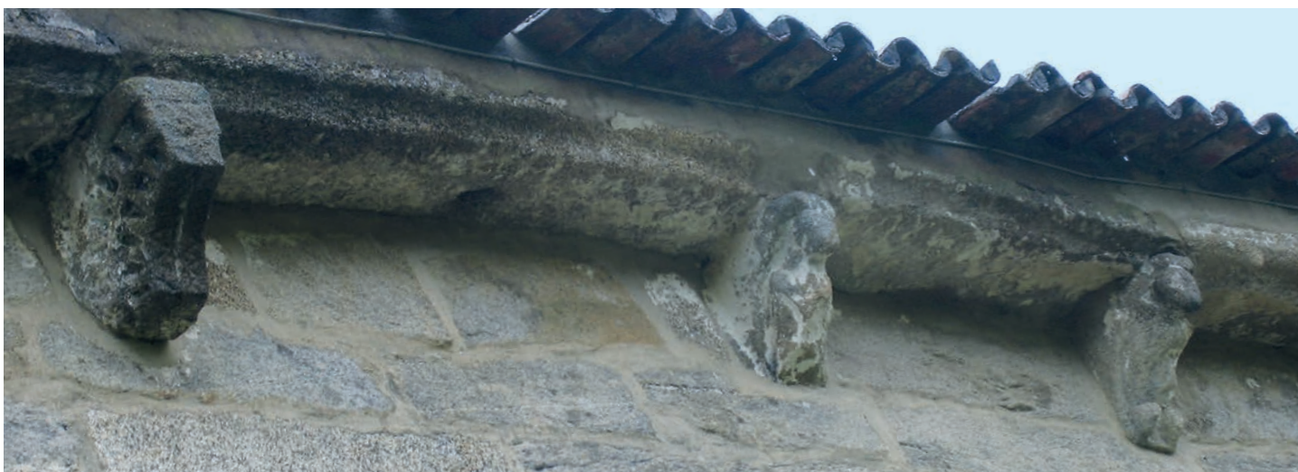
Fachada meridional. Canecillos
