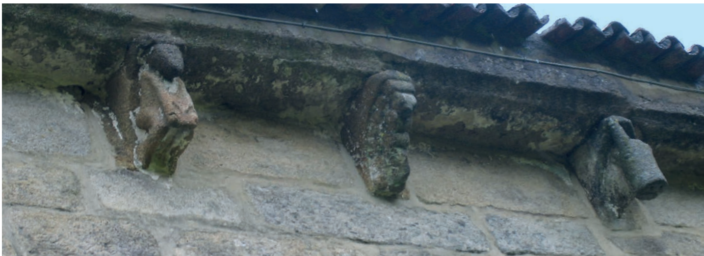
Fachada meridional. Canecillos
