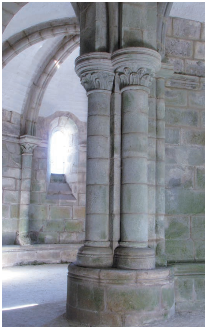
Columnas de la girola
