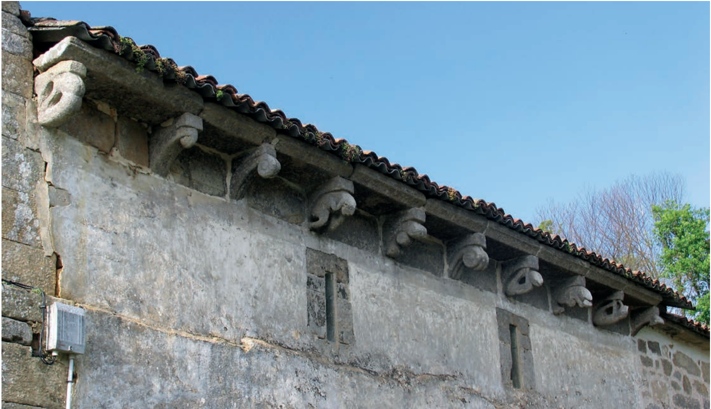
Canecillos del muro sur
