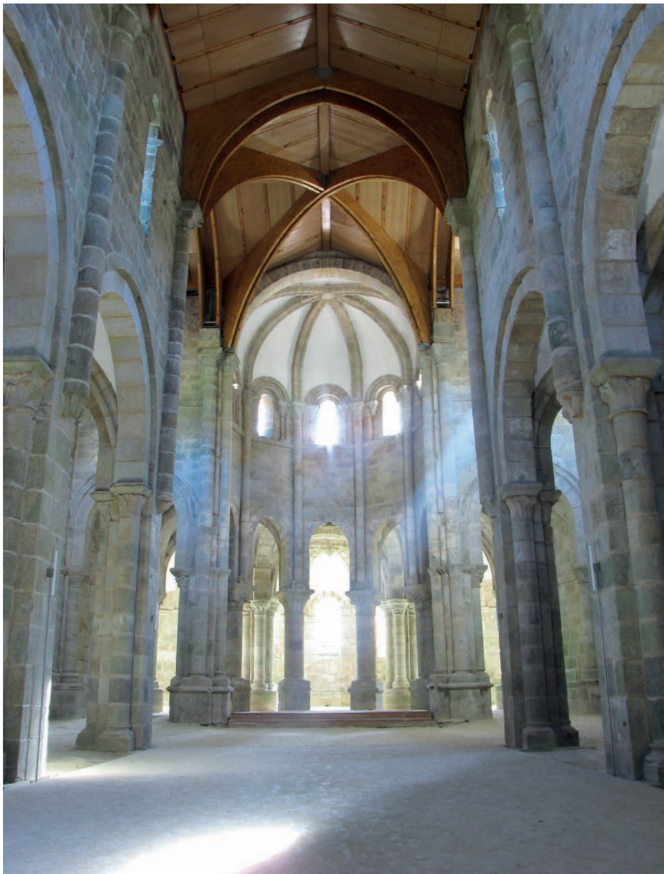
Interior de la nave central
