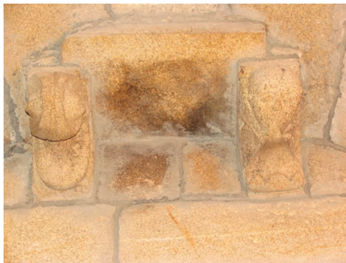
Sacristía. Canecillos que en origen sostenían el alero norte del ábside
