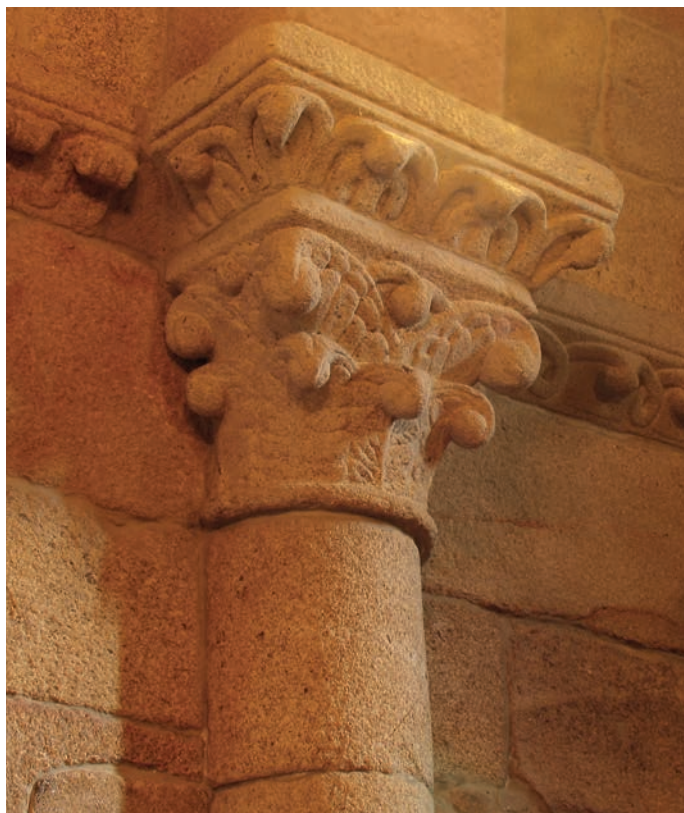
Capitel del ábside
