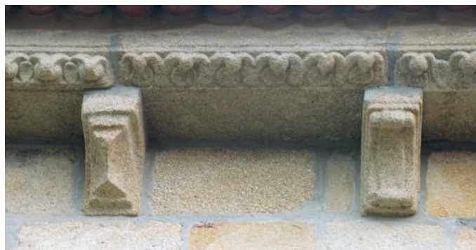
Fachada meridional de la nave. Canecillos
