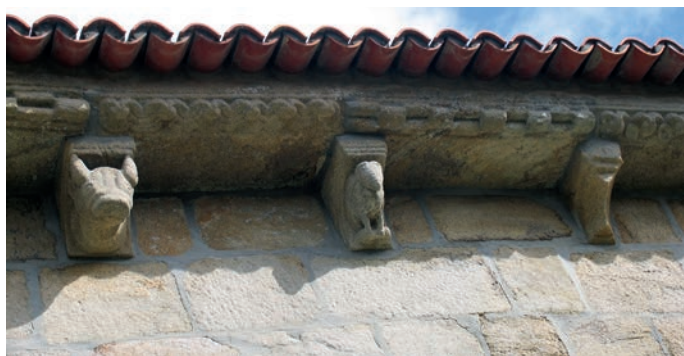
Fachada meridional de la nave. Canecillos
