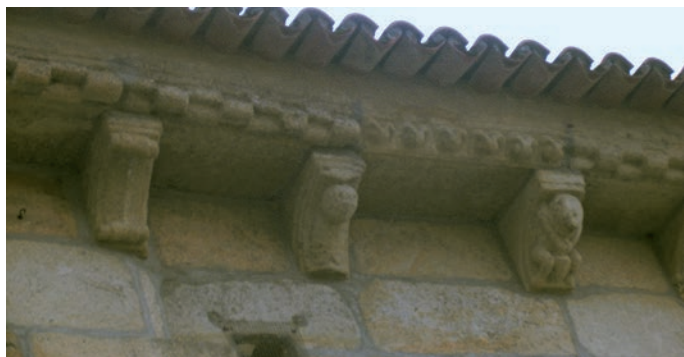
Fachada septentrional de la nave. Canecillos
