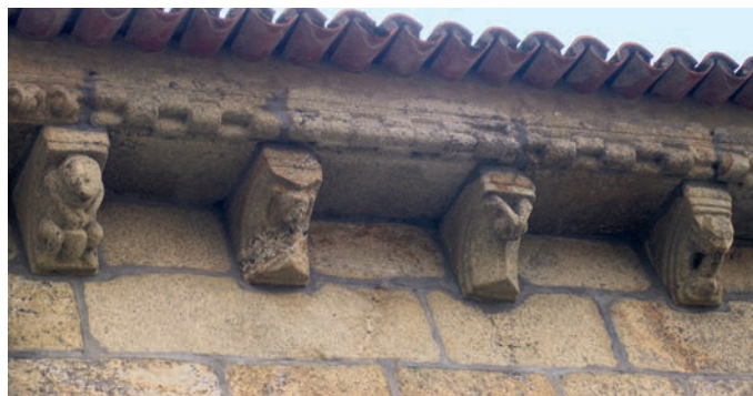
Fachada septentrional de la nave. Canecillos
