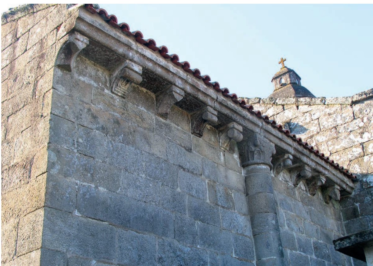
Canecillos del paramento septentrional del ábside
