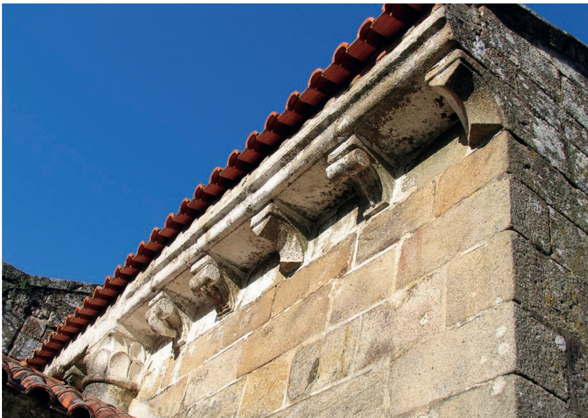
Canecillos del muro meridional del ábside
