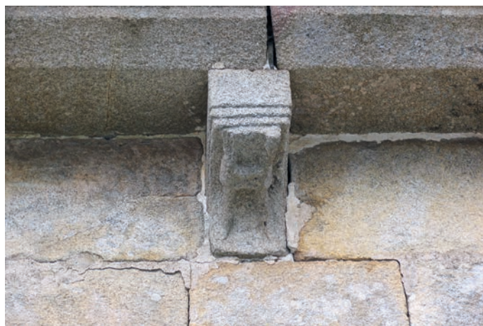
Muro sur y canecillo de la nave
