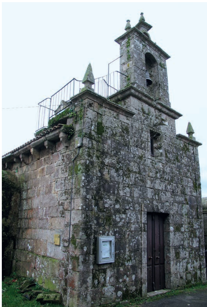
Fachada occidental y muro norte
