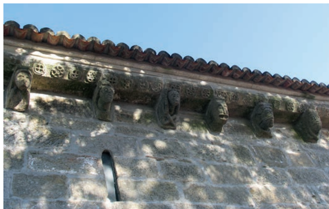
Alzado sur. Detalle del alero y canecillos
