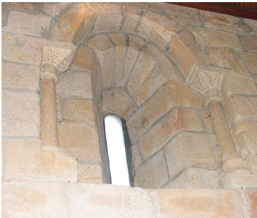
Ventana del muro norte
