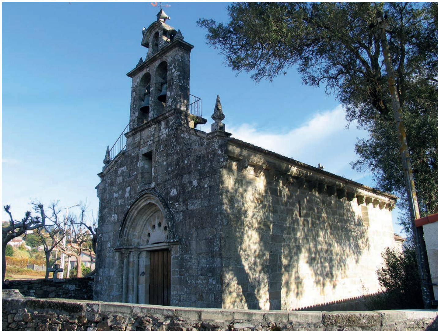
Fachadas occidental y sur
