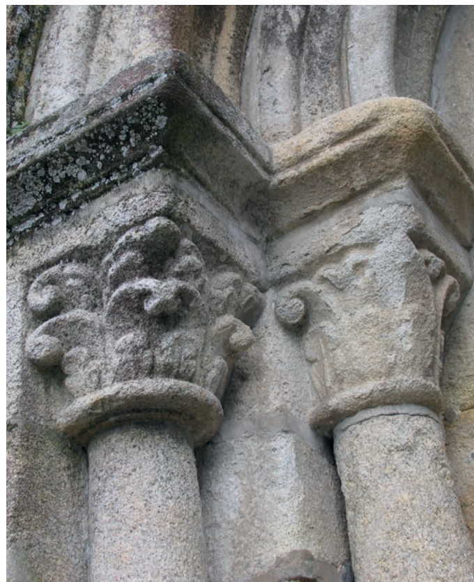
Portada. Detalle de las columnas
