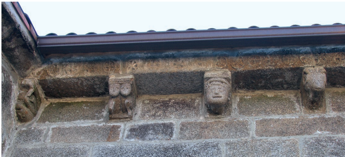
Canecillos del muro norte
