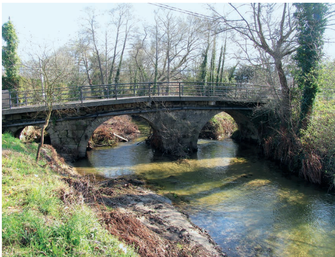
Vista del puente
