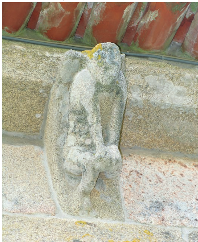
Canecillo del muro sur. Espinario
