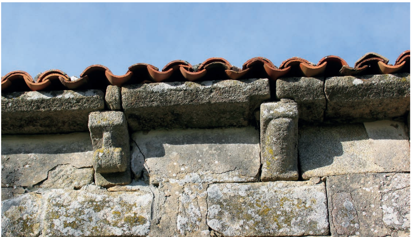
Canecillos del muro sur
