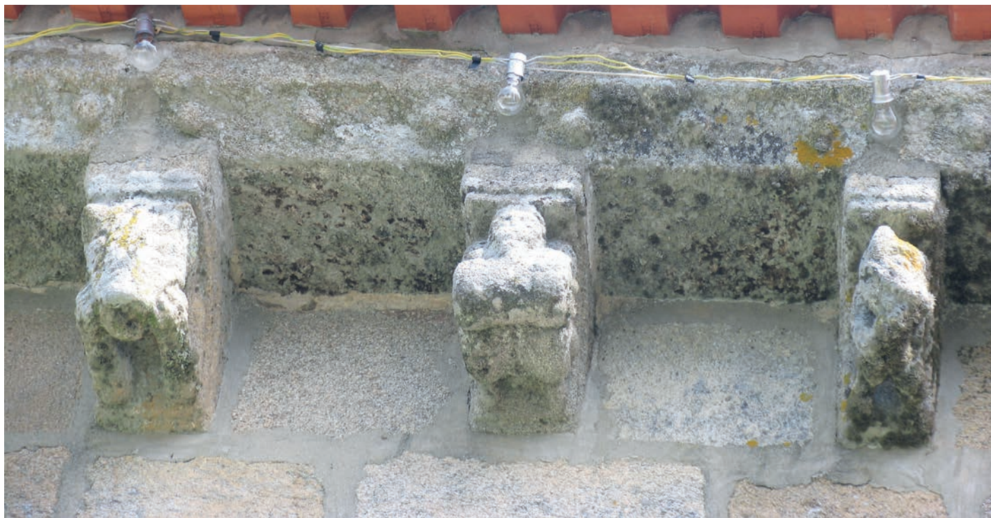
Canecillos del muro sur
