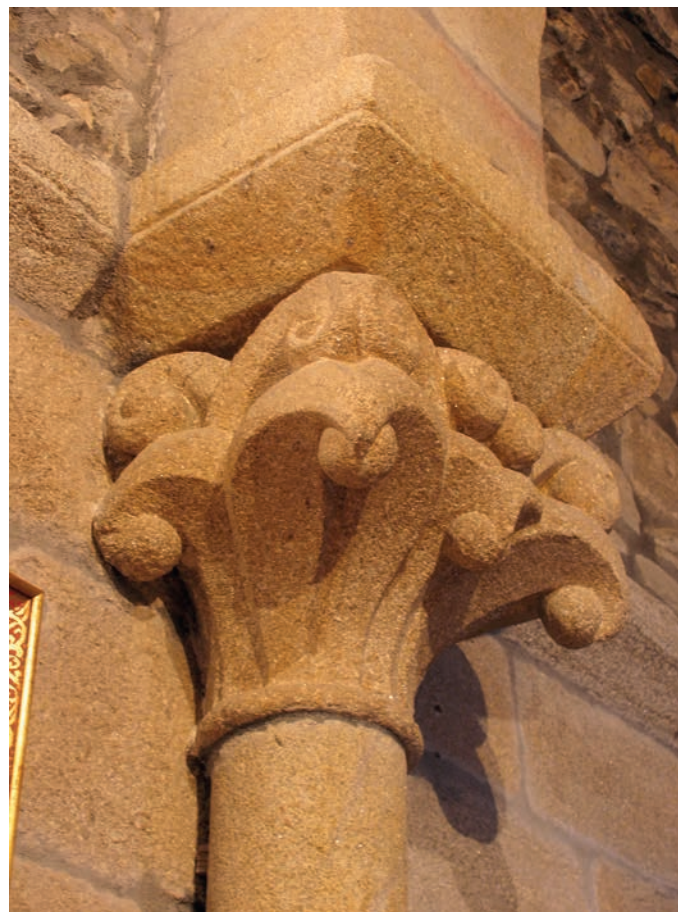
Arco fajón del presbiterio. Capitel de la columna septentrional
