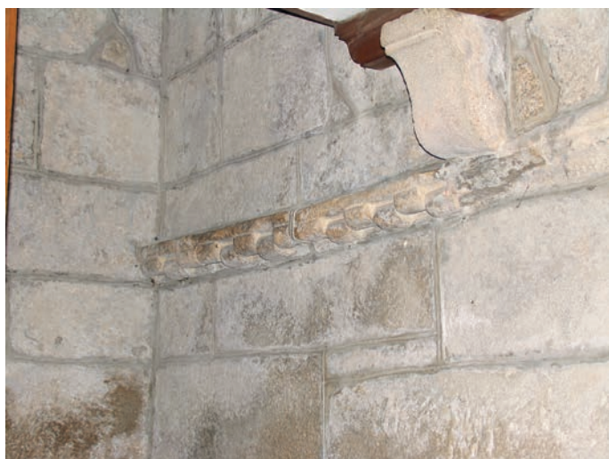
Arriba, capiteles de la portada occidental. Abajo, imposta del interior
