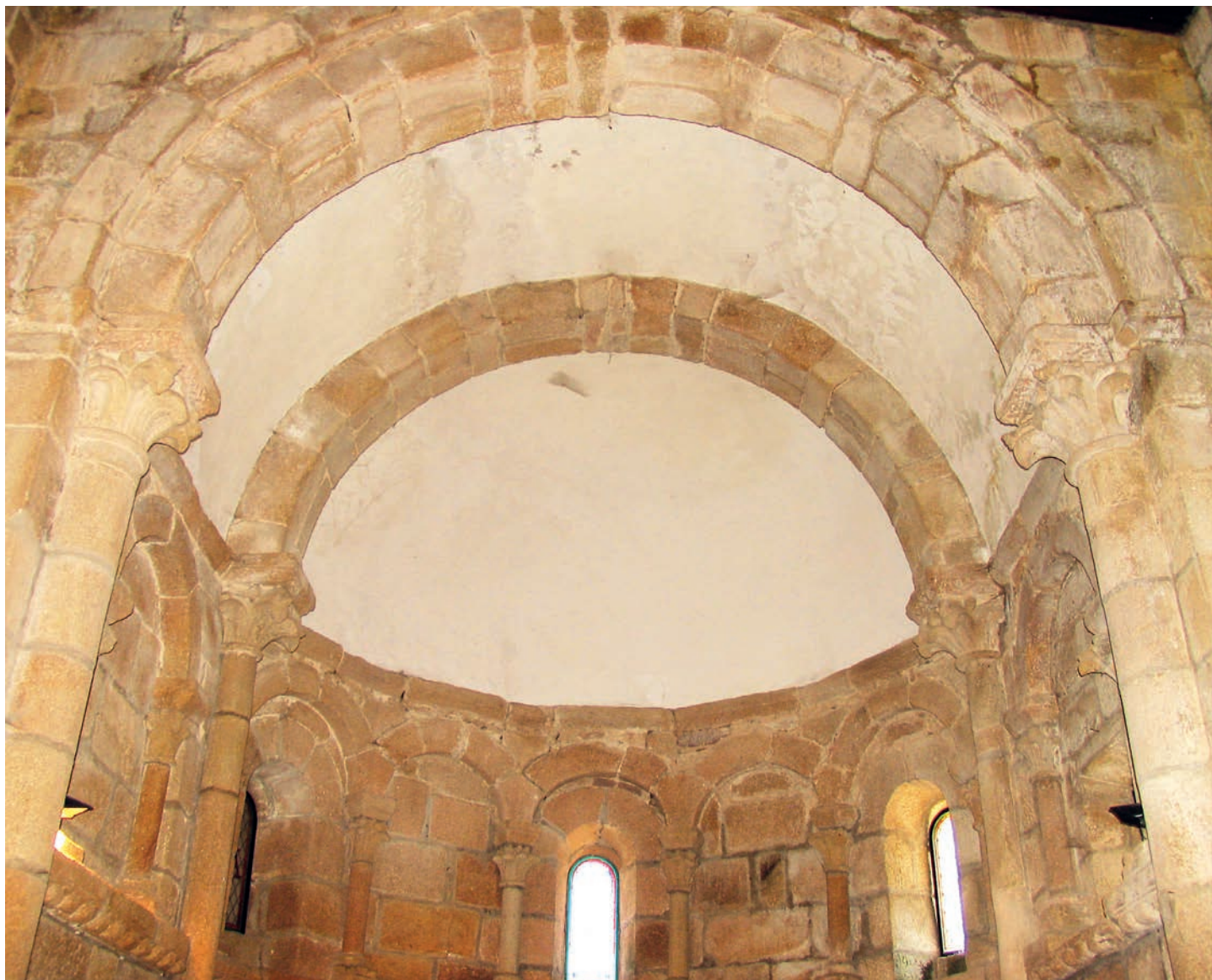
Interior del ábside
