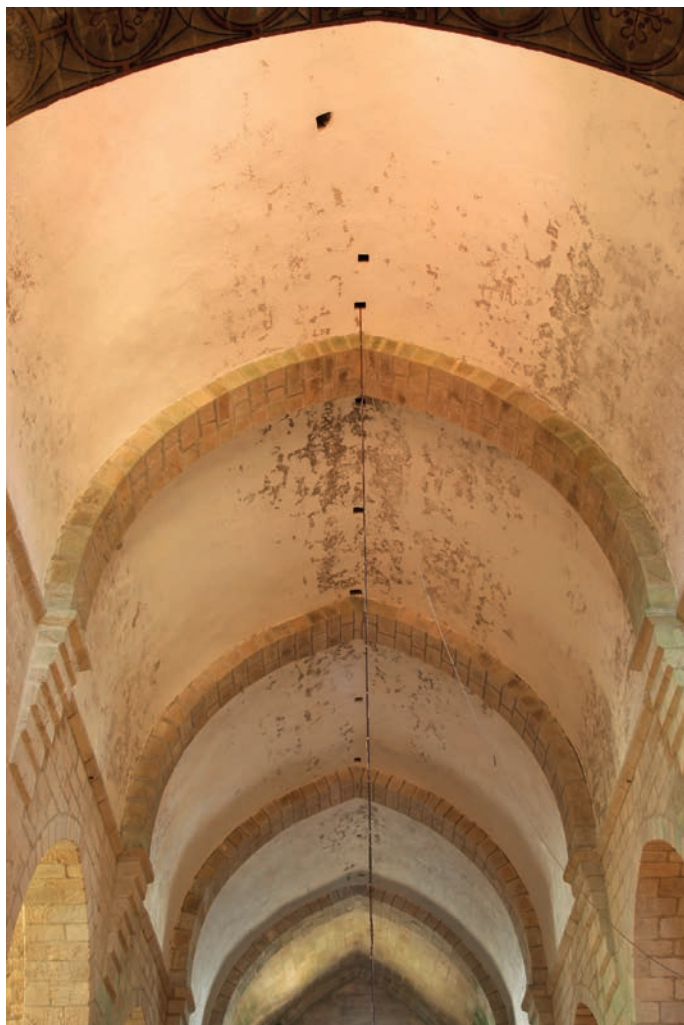
Bóveda de la nave central
