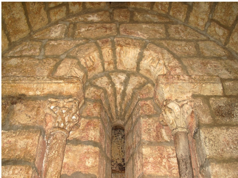
Ventana del interior
