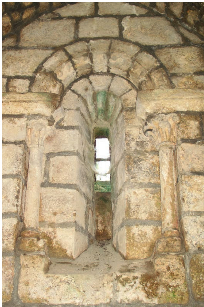
Ventana del interior
