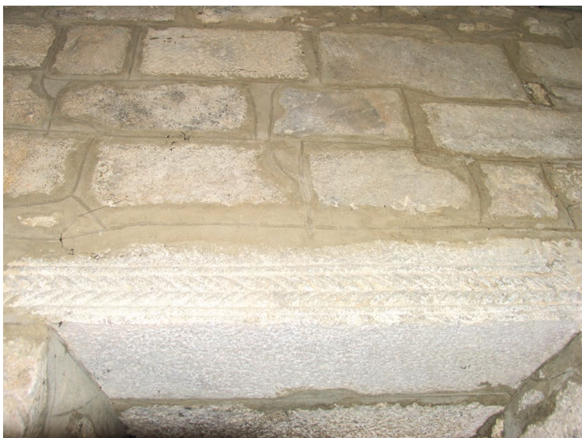
Dintel de la puerta de la sacristía
