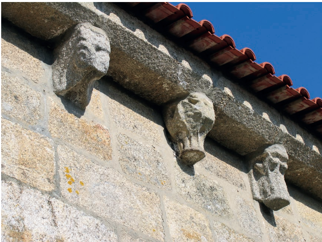
Canecillos del muro sur
