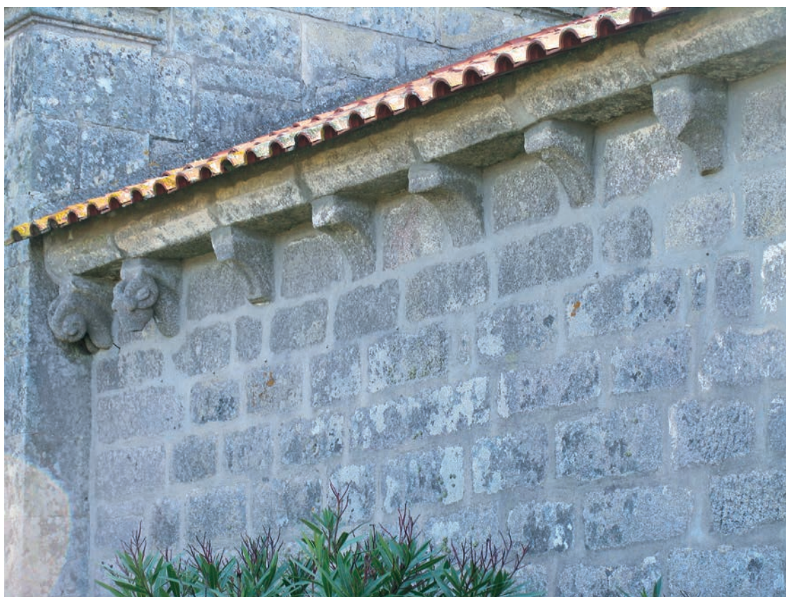
Canecillos del muro norte
