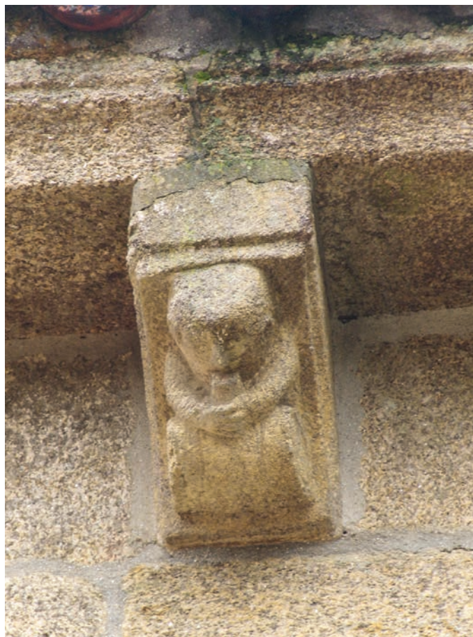
Canecillo del muro norte
