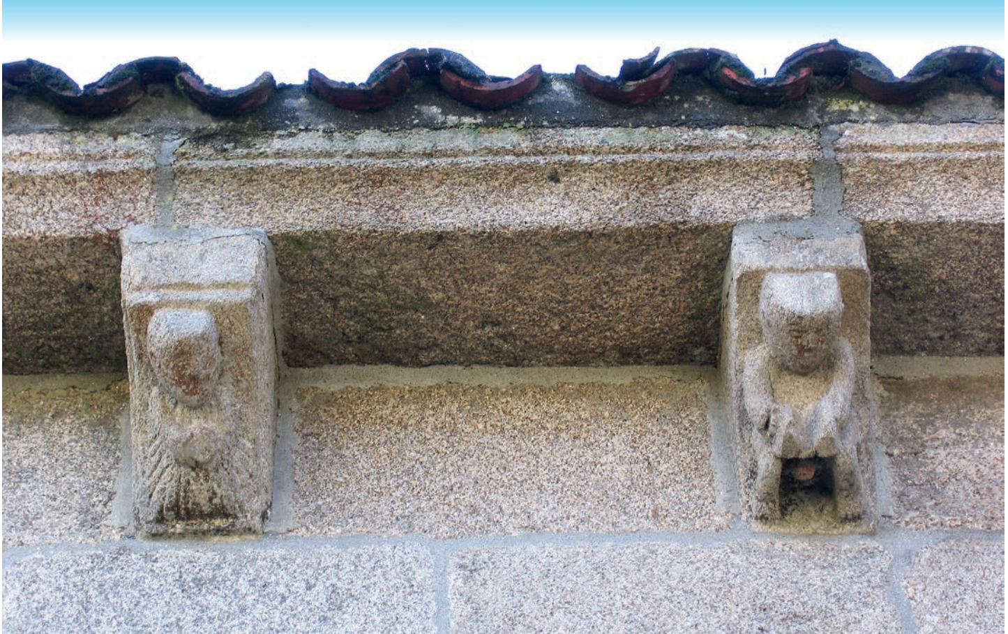
Canecillos del muro norte
