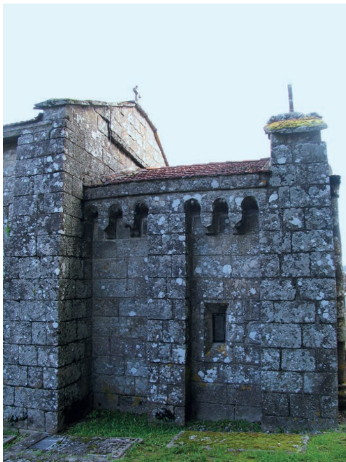
Muro sur de la cabecera
