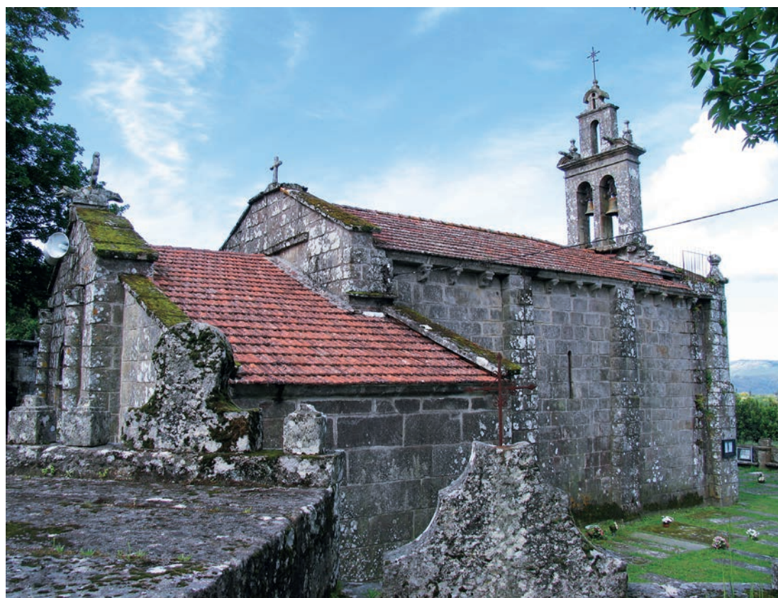
Vista desde el lado sureste
