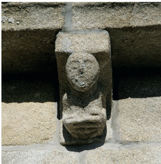
Canecillo del muro sur
