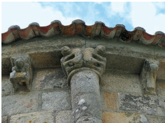
Alero del ábside
