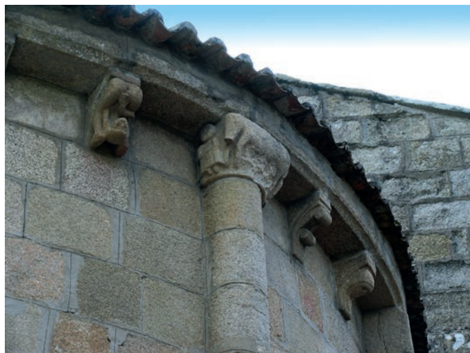
Alero del ábside
