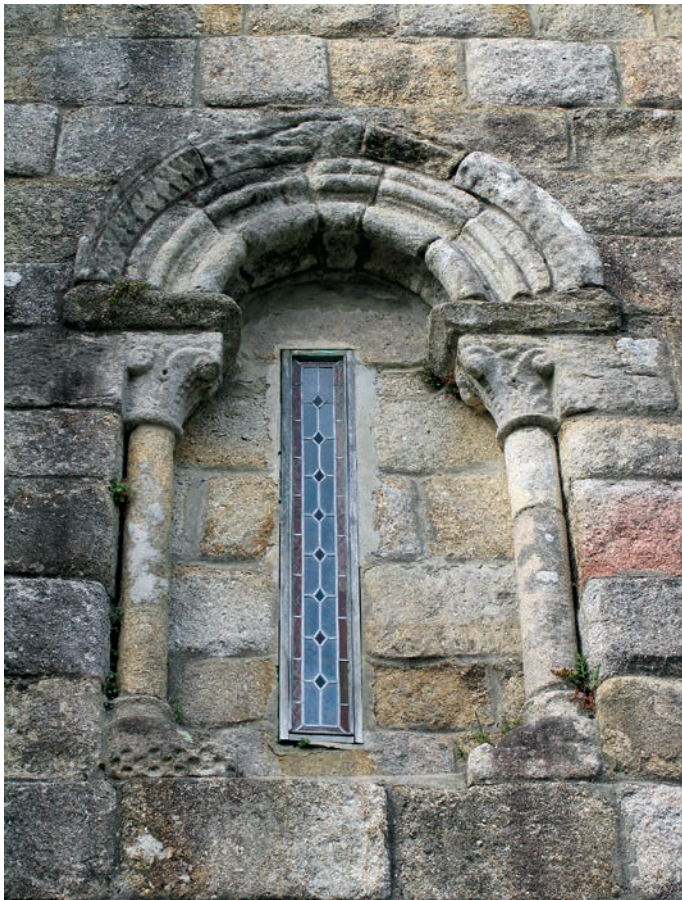
Ventana del muro sur
