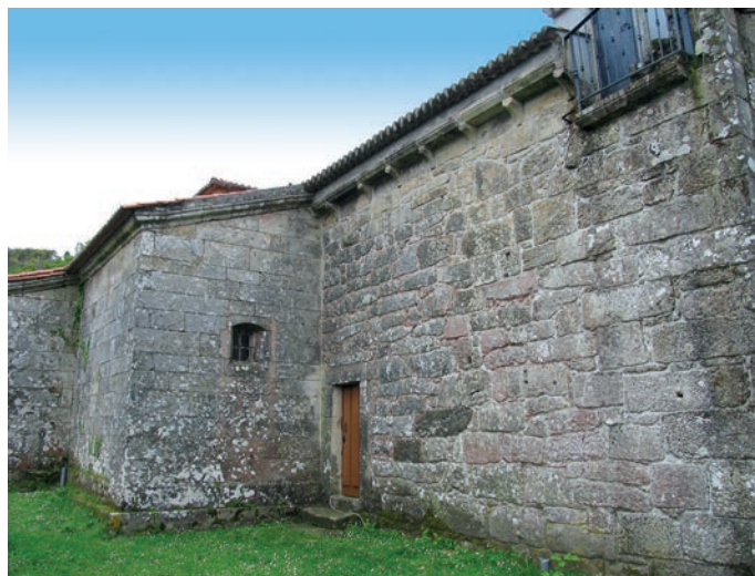
Muro norte de la nave
