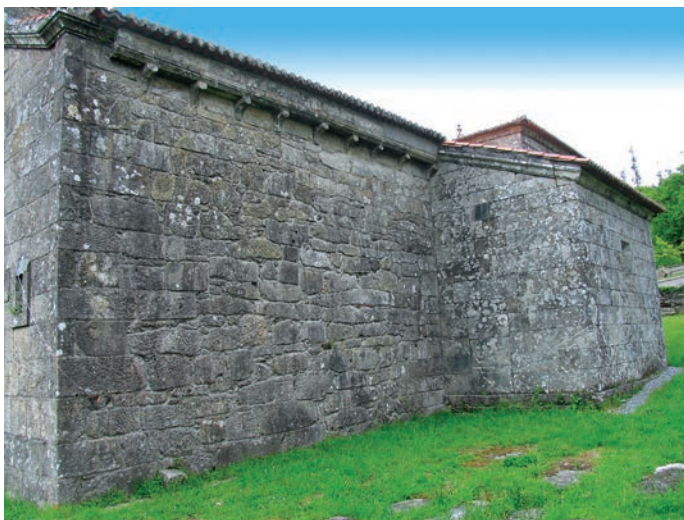
Muro sur de la nave
