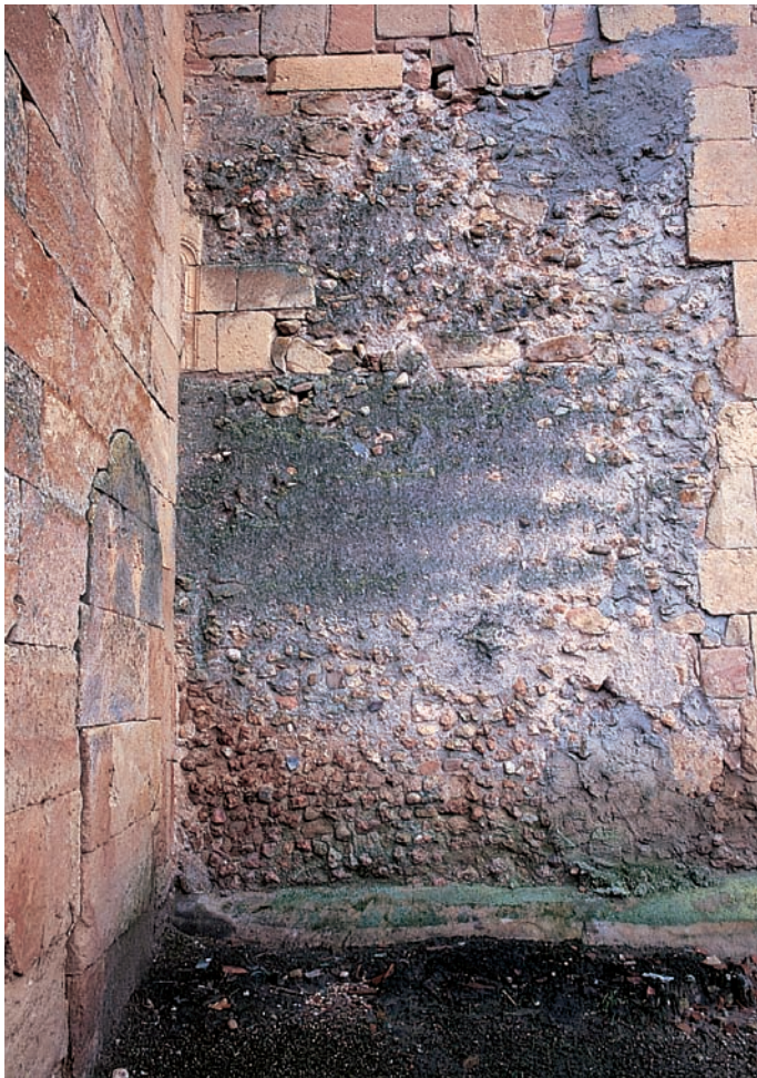
Paramento románico de cal y canto en el muro norte
