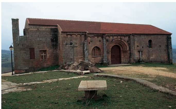
Vista general de la fachada norte
