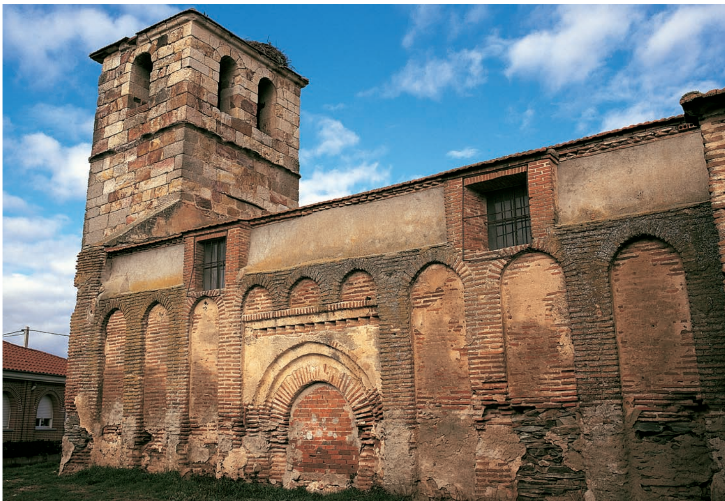
Muro sur de la nave
