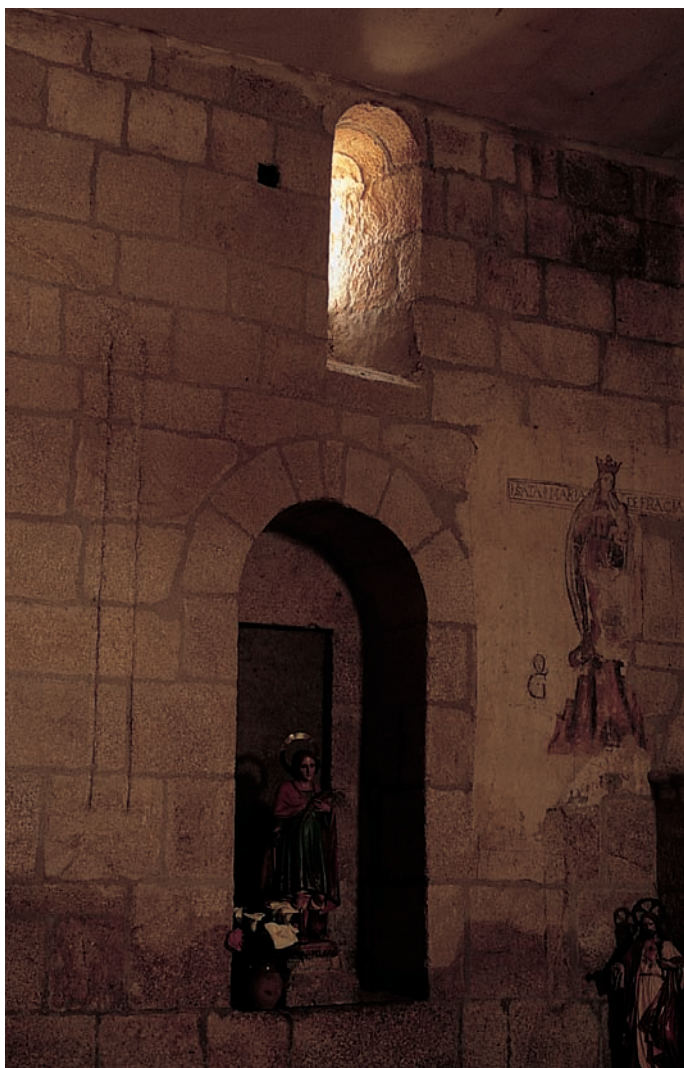
Detalle del muro del evangelio
