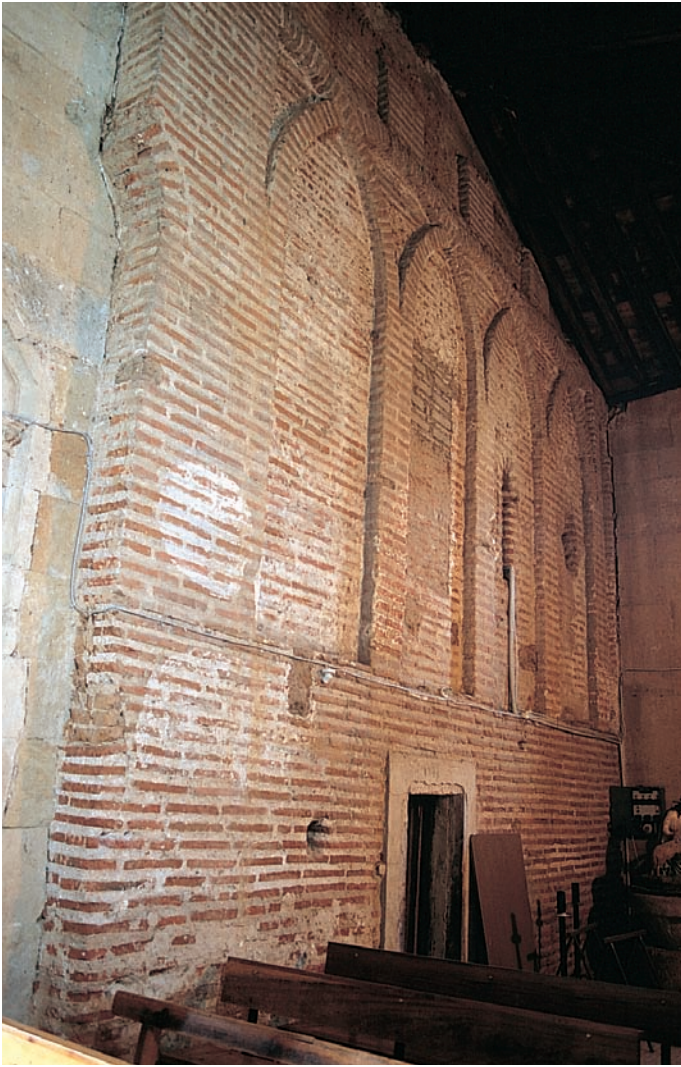
Muro norte de la torre
