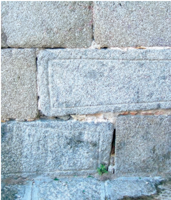
Sillares reutilizados de procedencia desconocida en la base de un muro contrafuerte de la iglesia de San Millán en Segovia
