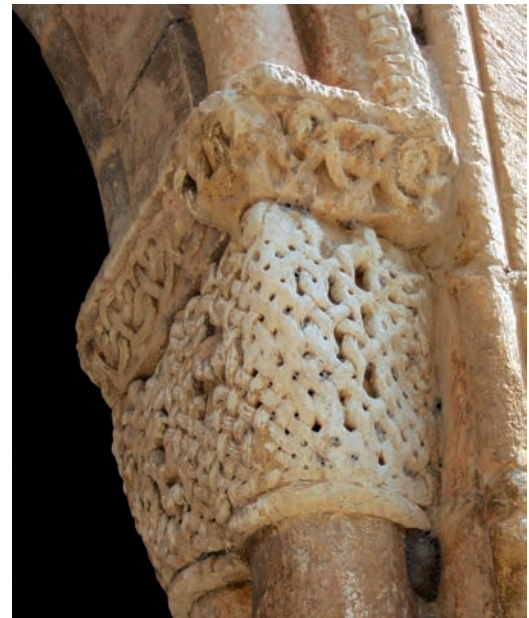
Empleo de dolomías blanquecinas en los materiales más escultóricos (arquivoltas, capiteles, fustes y basas) en una ventana del ábside de San Andrés (izquierda) y en la galería porticada de San Juan de los Caballeros (derecha) de Segovia
