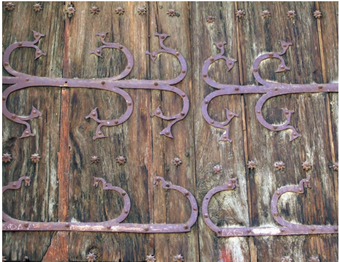
Elementos metálicos de hierro en una de las puertas de la iglesia de San Millán de Segovia
