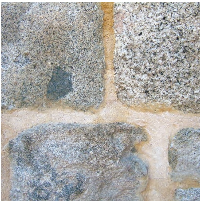
Sillares en la base de la torre de San Millán de Segovia, formados por granitoides, con diferentes texturas (equicristalina y porfídica), y presencia de xenolitos microdioríticos.
