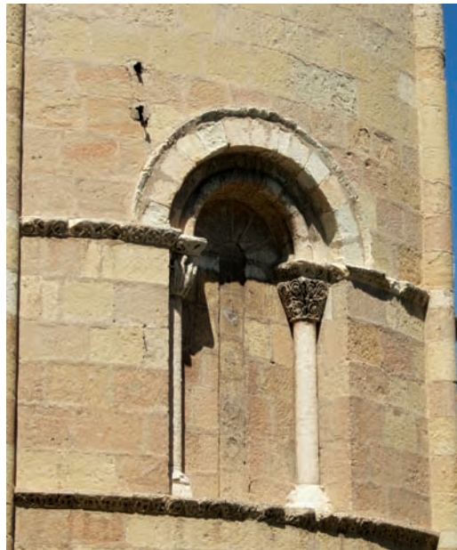
Empleo de dolomías blanquecinas en los materiales más escultóricos (arquivoltas, capiteles, fustes y basas) en una ventana del ábside de San Andrés (izquierda) y en la galería porticada de San Juan de los Caballeros (derecha) de Segovia
