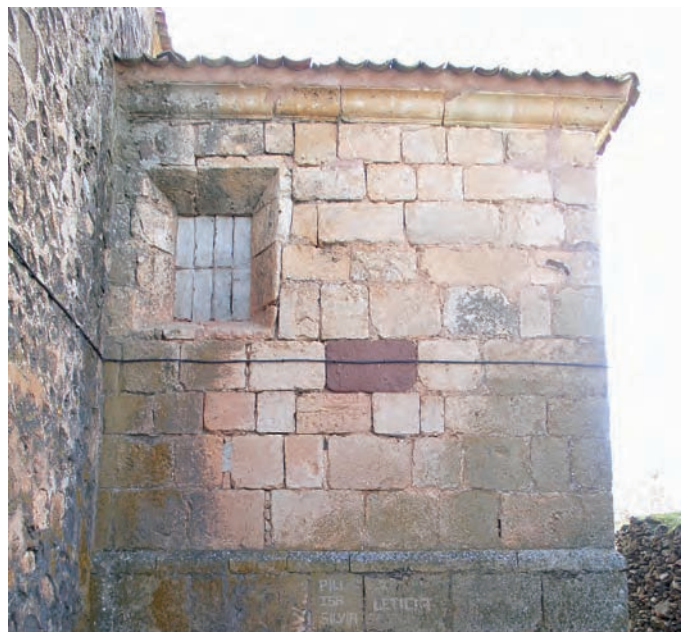
Sillar de areniscas triásicas (pardo-rojizo) en un muro de sillares de dolomías, formando parte de la iglesia de San Pedro (Grado del Pico). Foto: E. M. Pérez (2006)
