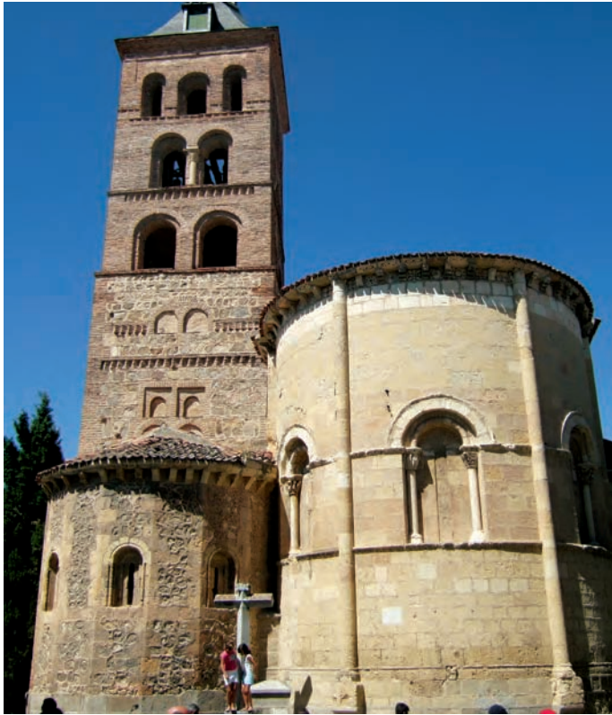
Combinación de materiales pétreos en la iglesia de San Andrés de Segovia: granitoides, calizas, dolomías, gneises y ladrillos
