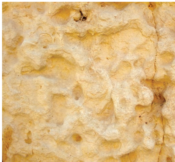
Detalle de las calizas y dolomías de los sillares de la iglesia de La Trinidad (Segovia), donde se aprecian las bioturbaciones, y cómo controlan la alteración de la roca.
