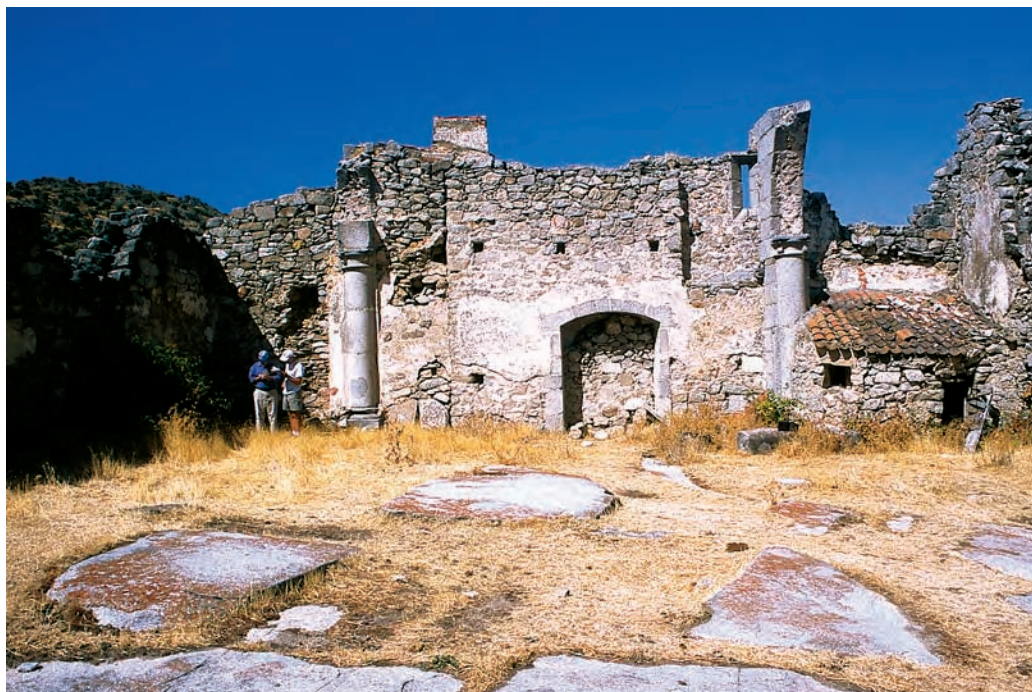
Ermita de Nuestra Señora de la Losa (El Espinar), formada íntegramente por granitoides, sobre los cuales además se construyó, y de cuyas morfológicas (losas o lancharas) toma el nombre. Foto: José Francisco Martín Duque
