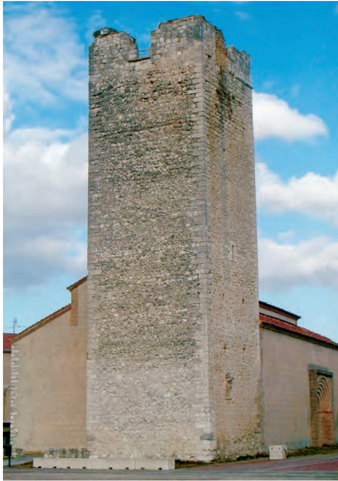
Torre de la antigua iglesia de San Miguel de Cuéllar, formada en su integridad por 'calizas de los páramos'
