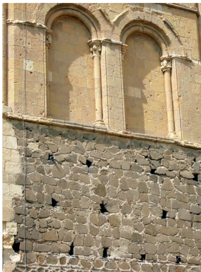
Mampostería de granitoides en los cuerpos inferiores de la torre de la iglesia de los santos Justo y Pastor (Segovia), pueden proceder de la excavación en la propia cimentación del edificio
