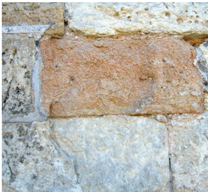
Sillar de areniscas dolomíticas anaranjadas entre calizas y dolomías micríticas, resaltando por la diferente coloración y el patrón de alteración. Iglesia de San Millán de Segovia
