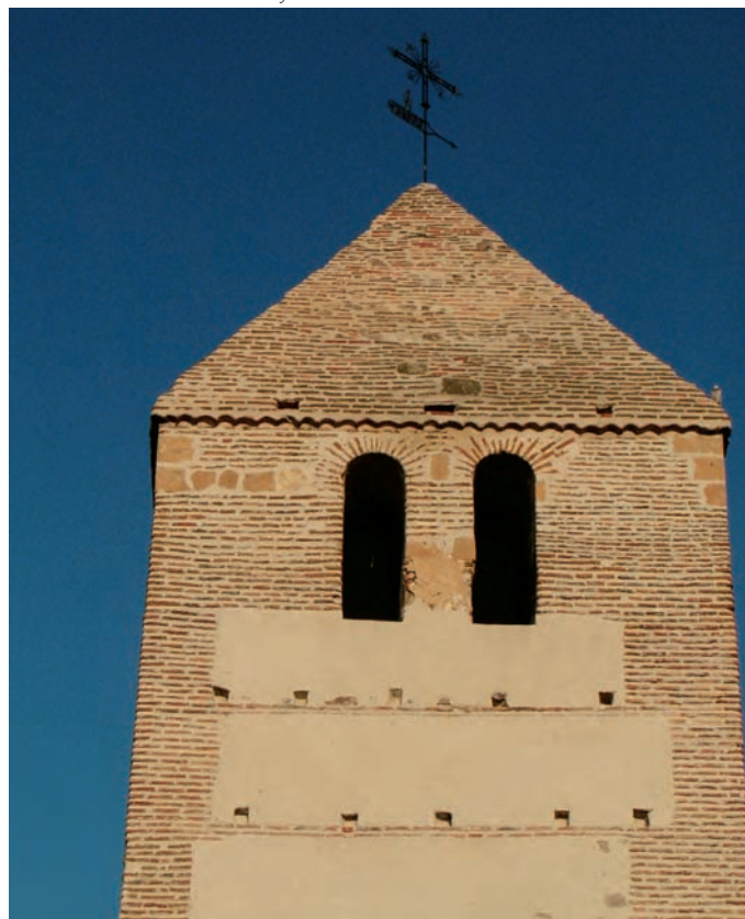
La torre de la iglesia de Nuestra Señora de la Asunción de Pinarejos emplea los ladrillos incluso en la cubierta del tejado
