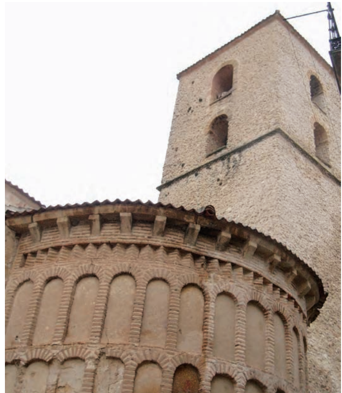
Combinación de materiales pétreos (mampostería y sillería de calizas y dolomías) con ladrillos del ábside, en la iglesia de Santiago de Sepúlveda
