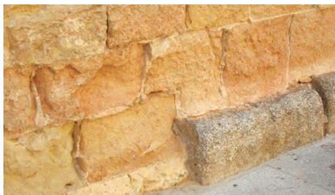
Sillares de granitoides en la base de un muro de la iglesia de La Trinidad de Segovia, colocados para evitar el ascenso de humedad por capilaridad, que produce el deterioro de la roca en menor medida que en la parte izquierda (sin granitoides)
