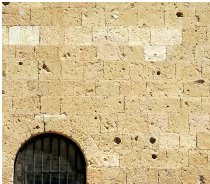
Geodas redisueltas formando macro-cavidades en los sillares de dolomías de la base de la torre de San Esteban de Segovia, a diferencia de los sillares de la parte superior, repuestos en la reconstrucción
