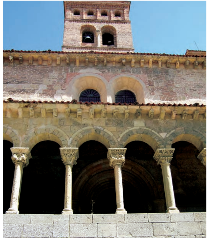
Combinación de materiales pétreos en la iglesia de San Martín de Segovia: granitoides, calizas, dolomías y ladrillos
