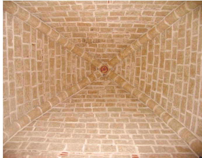
Bóveda de la capilla sur
