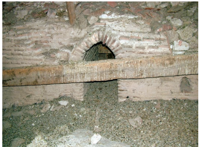
Acceso a bajocubierta
