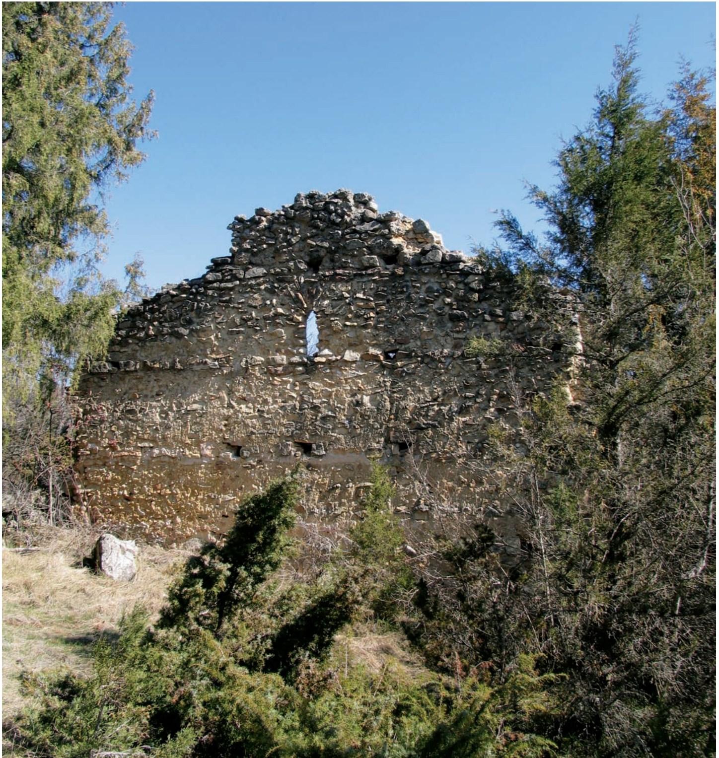
Vista desde el oeste
