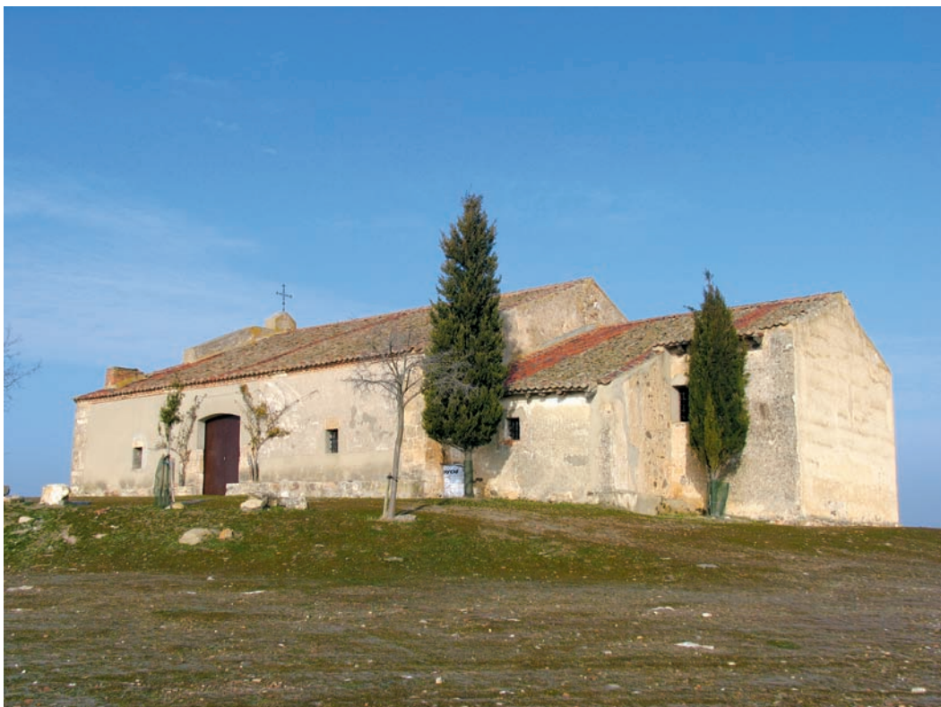
Vista de la ermita desde el sureste
